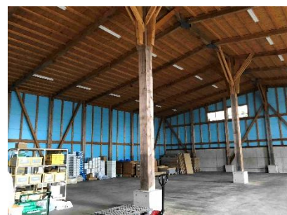
新工場内部(射出成型機を設置予定)
