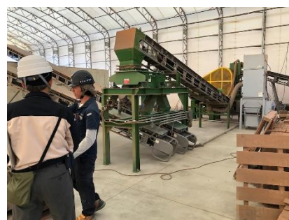
粉体ふるい機の動作を確認
