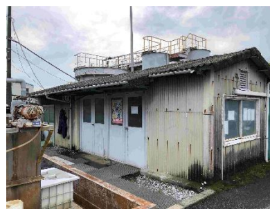
屋根への遮熱対策を予定している6号棟
