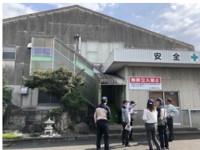
遮光対策が施された窓
