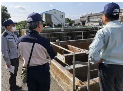
排水処理場のモーターを確認
