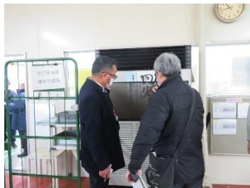
空調機フィルターを確認
