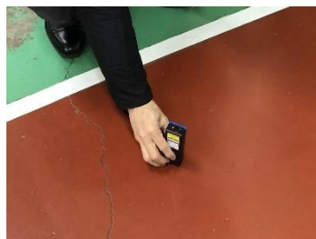
工場内の高さを確認
