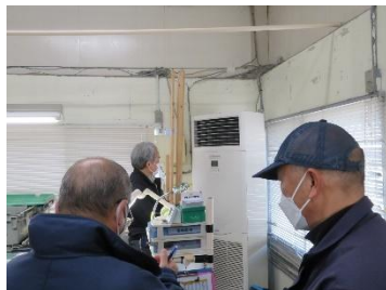
各棟の空調機を確認
