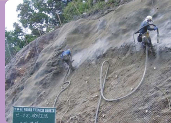
法面への吹付作業
