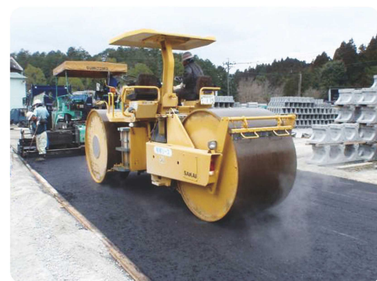
自社敷地内での施工実験。フライアッシュのうち、未燃焼炭素分の少ないJISⅢ種適合品はアスファルト合材としての性能を満足することが確認できました
