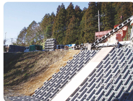
ポーラスコンクリート連節ブロックを法面に設置していきます。この上にパーク堆肥を吹き付けます
