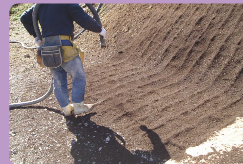
法面に吹き付けられる「ひむかパーク」
