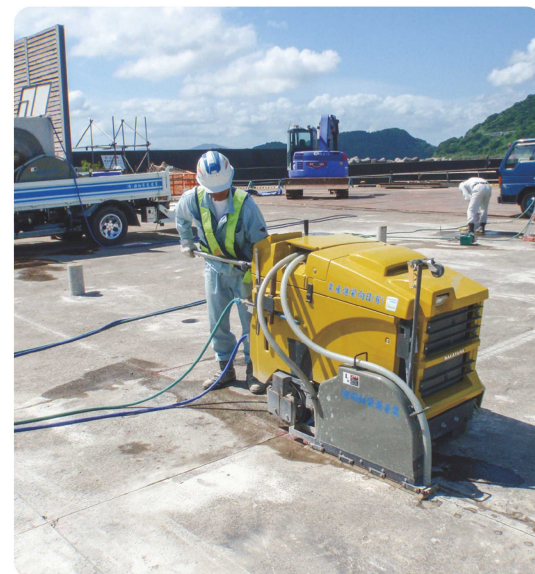
ひむか式固液分離汚水処理システムで 多くの橋を解体しています
