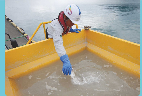
回収したコンクリート切削廃液にかたるまくんを投入
