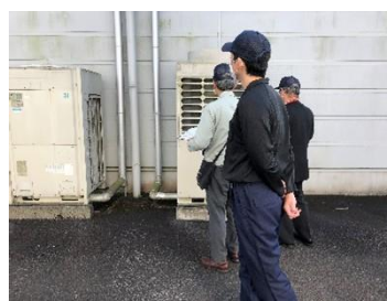
室外機を確認
