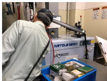
コンプレッサーを確認
