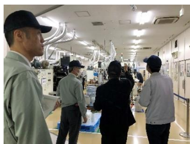
照明・空調吹き出し口を確認
