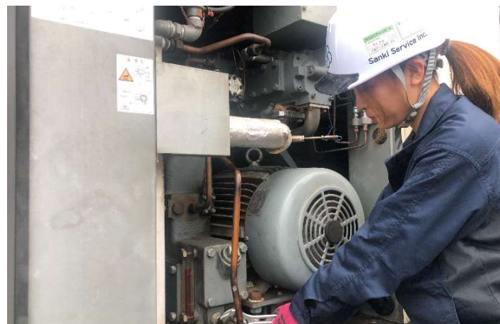
▲コンプレッサー整備
