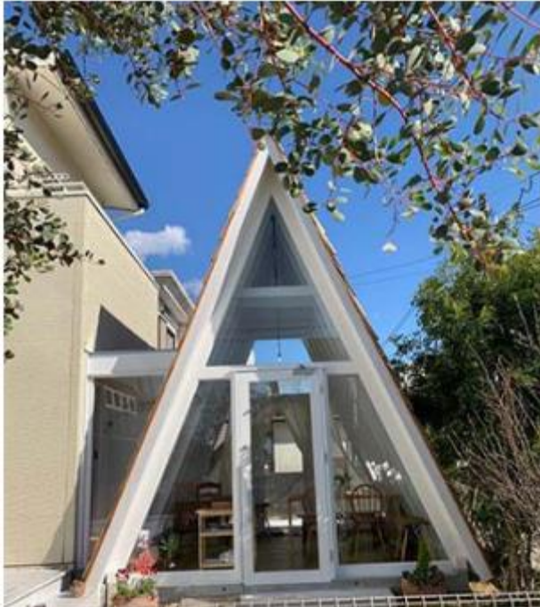
◀カフェの外観
