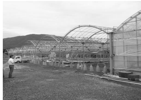
取材時、行われていた増床工事の様子
