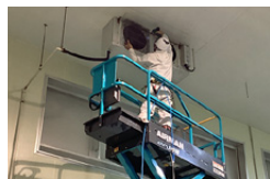
▲空調機洗浄作業
