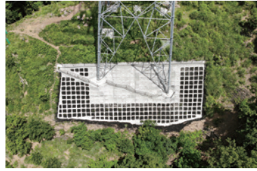
送電鉄塔敷地保全工事
